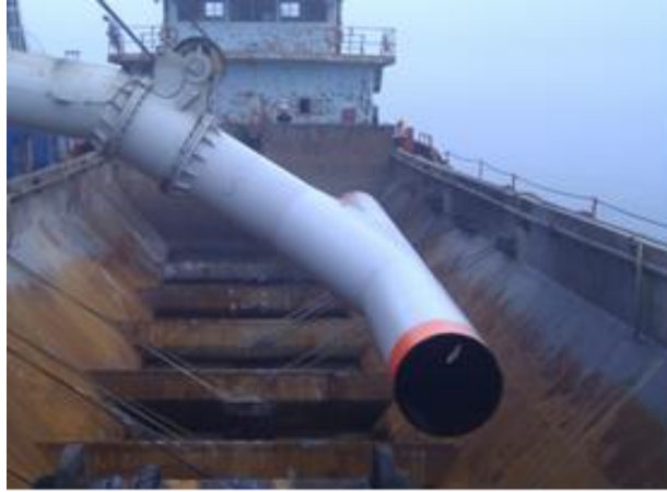
图 2.3-4 作业平台 T 型消能管装驳现场图
