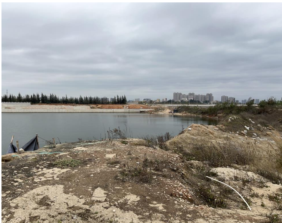
图 3.2-18 纳泥区周边现状
