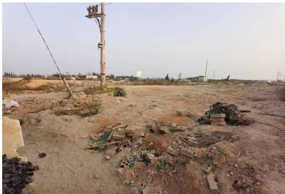
图 3.2-19 陆域临时施工场地现状
